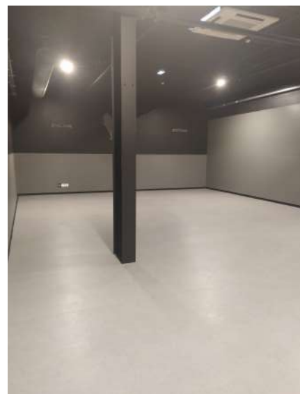
Remplacement de sol (Basic Fit)
