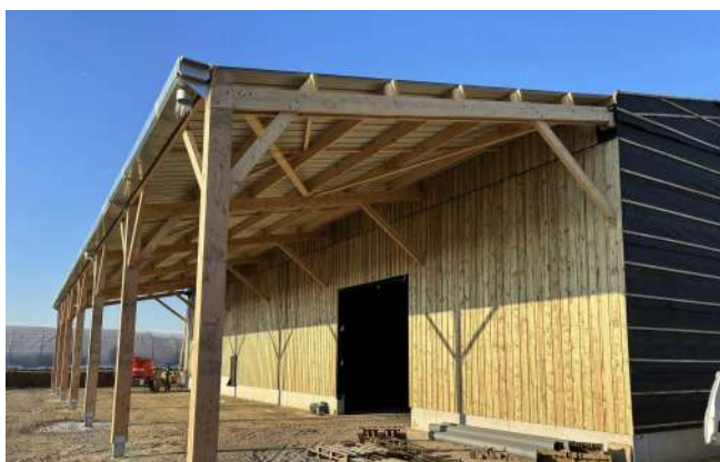
Bâtiment industriel à ossature bois
