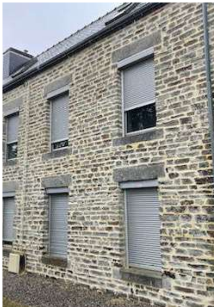
Dépiquetage et création de joints
