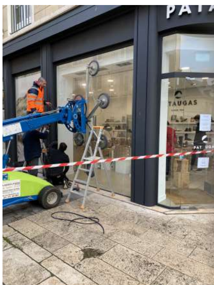
Remplacement de vitrine (Pataugas)
