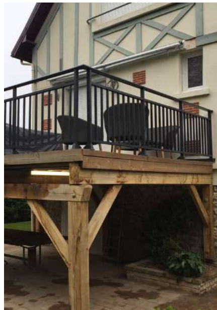
Création de terrasse sur pilotis
