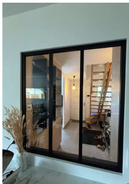
Pose de verrière
